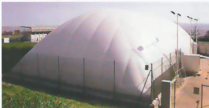
Vista esterna di pressostruttura a doppia membrana.
