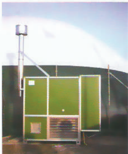
Generatore di aria calda per pressostruttura.
