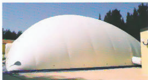
Vista esterna di pressostruttura a volta ribassata ad uso piscina.
