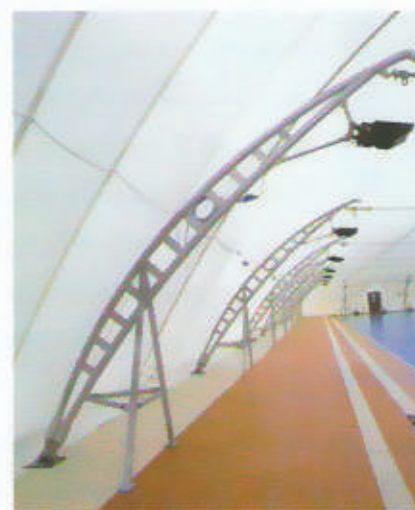
Palo anti-afflosciamento rapido per pressostruttura ad uso piscina.
